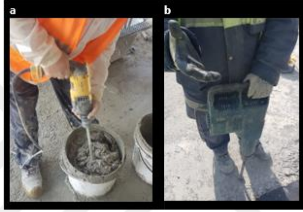
Şekil 5. Şantiye sahasında kullanılan bazı el-kol titreşimi kaynağı iş ekipmanları. a) Karıştırıcı, b) Kırıcı.
