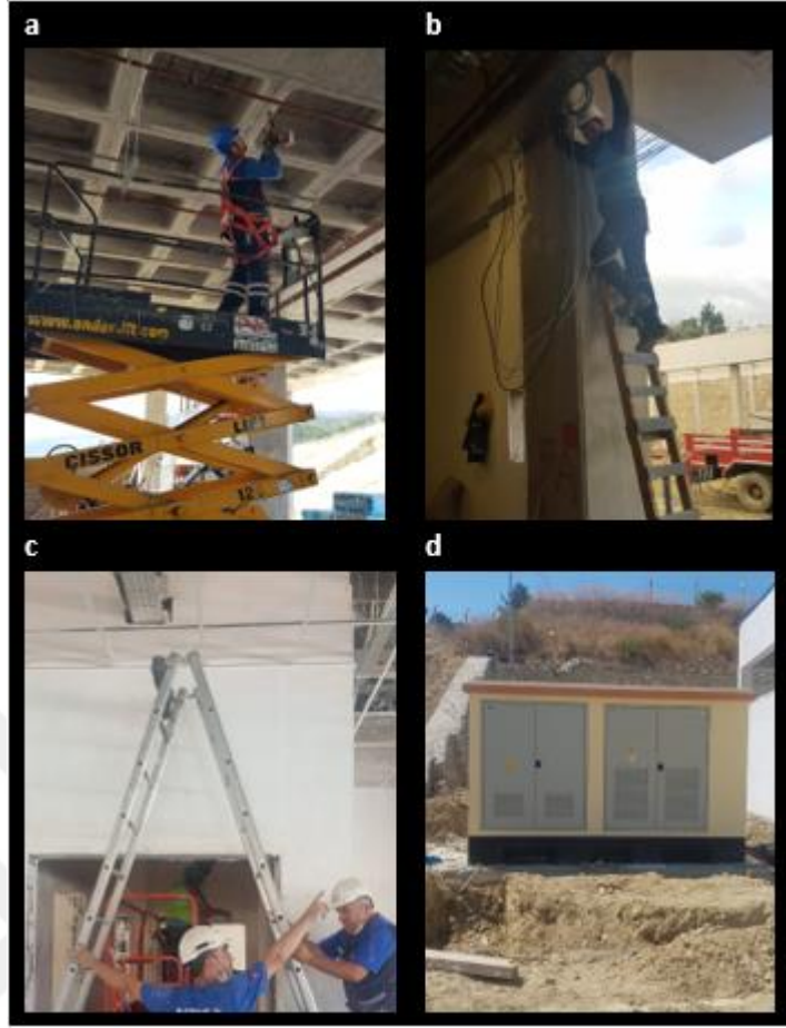
Şekil 2. Elektrik disiplini tarafından yürütülen bazı faaliyetler. a) Galvaniz kablo kanalı montajı, b) Data ve haberleşme kablolarının çekilmesi, c) Aydınlatma armatürlerinin bağlanması, d) Yerleştirilen trafo köşkü
