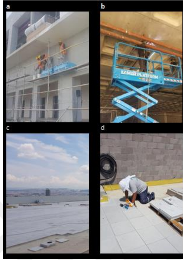
Şekil 6. Şantiye sahasında radyasyona maruz kalan çalışanlar. a) Cephe iskelesinde mantolama yapan çalışanlar. b) Yangın sistemleri boru montajında TIG kaynağı yapan çalışan, c) Üretim binasının tabliye bölümü, d) Tabliyede çalışan bir işçi.
