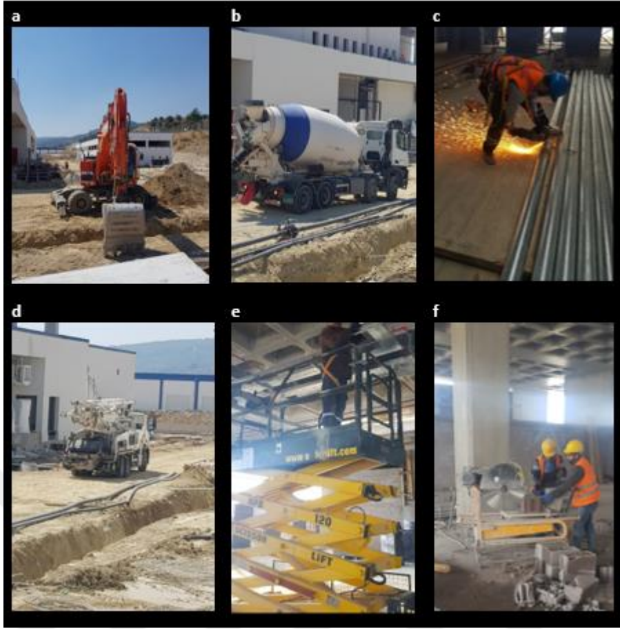
Şekil 4. Çalışma sahasında bulunan bazı gürültü kaynağı iş makineleri ve iş ekipmanları. a) Kazıcı, b) Beton mikseri, c) Spiral taşlama makinesi d) Beton pompası, e) Personel yükseltici, f) Duvar kesme makinesi
