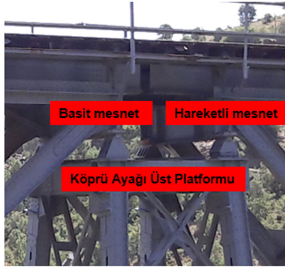
Şekil 64. Köprü ayağı mesnetleri
