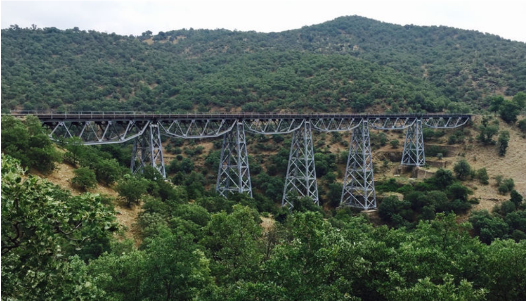
Şekil 5. 199+325 demiryolu çelik köprüsü
