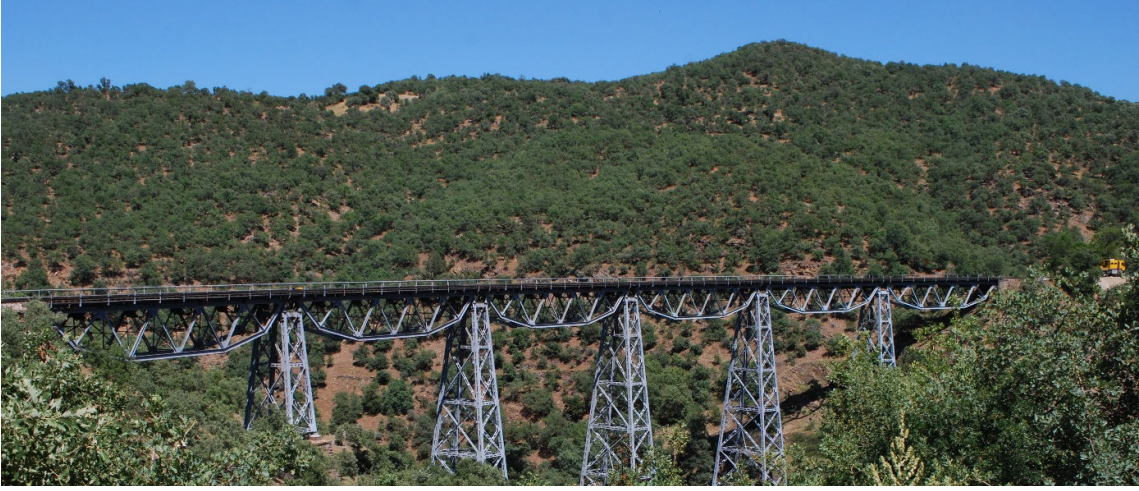
Şekil 1.199+325 Çelik demiryolu köprüsü genel görünümü
