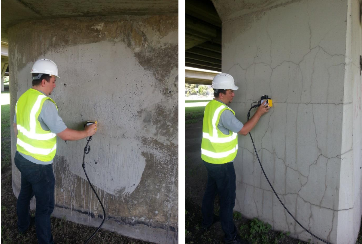
Şekil 2: Köprüsünün taşıyıcı ayağına Yer Radarı Uygulaması
