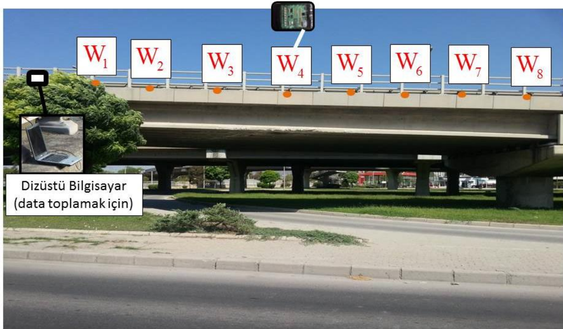
Şekil 4. KSA Sensörleri ve köprüden geçen kamyon [14].
