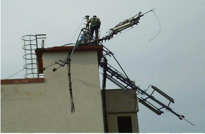
Resim 2. Çatı montajı (GSM Operatörü BÇO, 2007).
