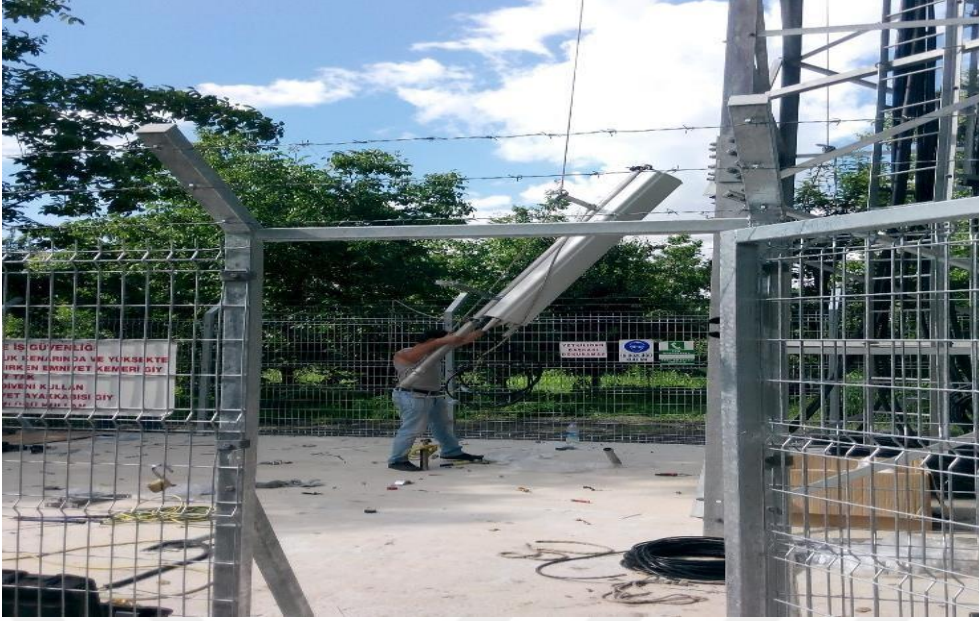
Resim 5. Kule montajı (GSM Operatörü BÇO, 2006).
