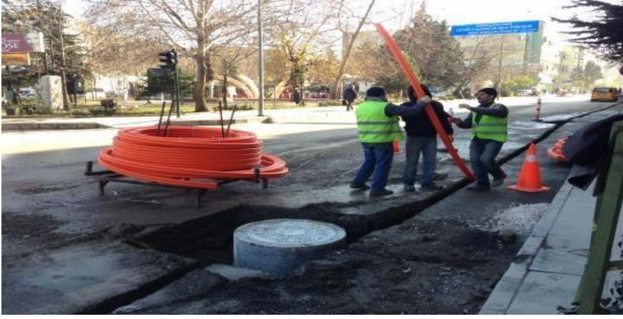
Resim 4. Altyapı işleri (GSM Operatör Fiber çekimi, 2013).
