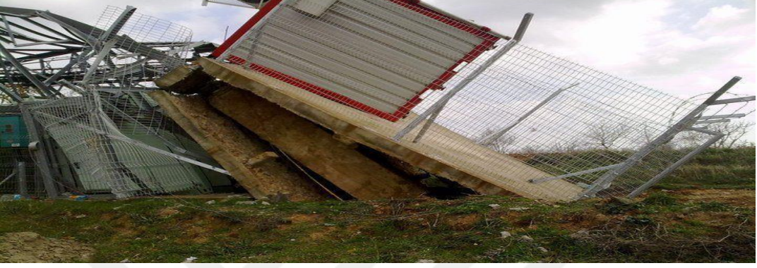
Resim 1. İstasyon üzerine yıkılmış kule (Vodafone BÇO, 2008).
