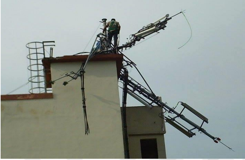
Resim 2. Çatı montajı (GSM Operatörü BÇO, 2007).
