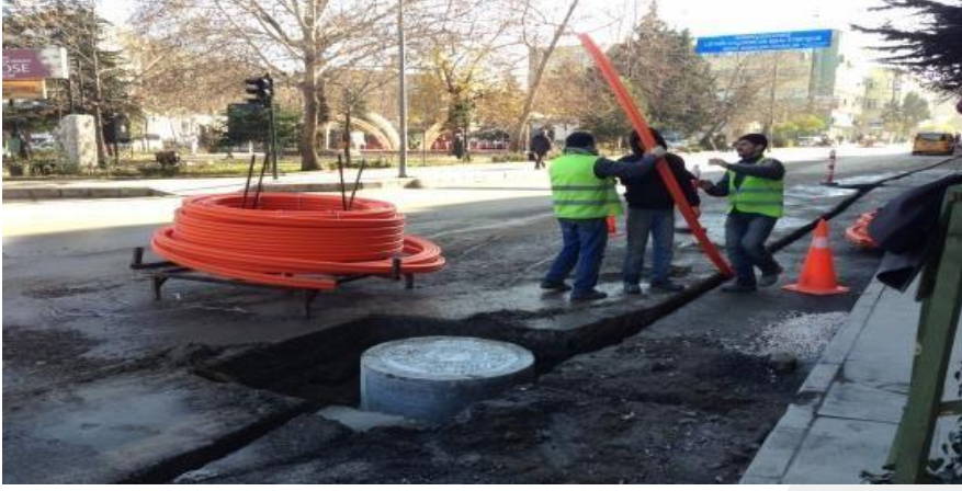
Resim 4. Altyapı işleri (GSM Operatör Fiber çekimi, 2013).
