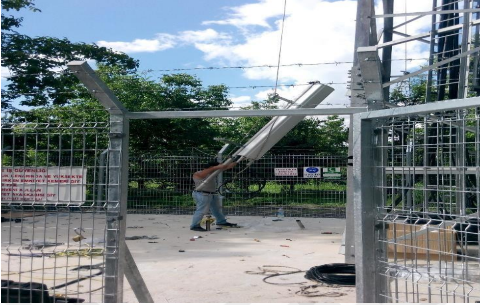
Resim 5. Kule montajı (GSM Operatörü BÇO, 2006).
